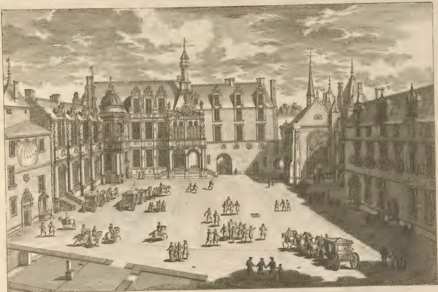
LA COUR DU CHÂTEAU DE CHANTILLY
