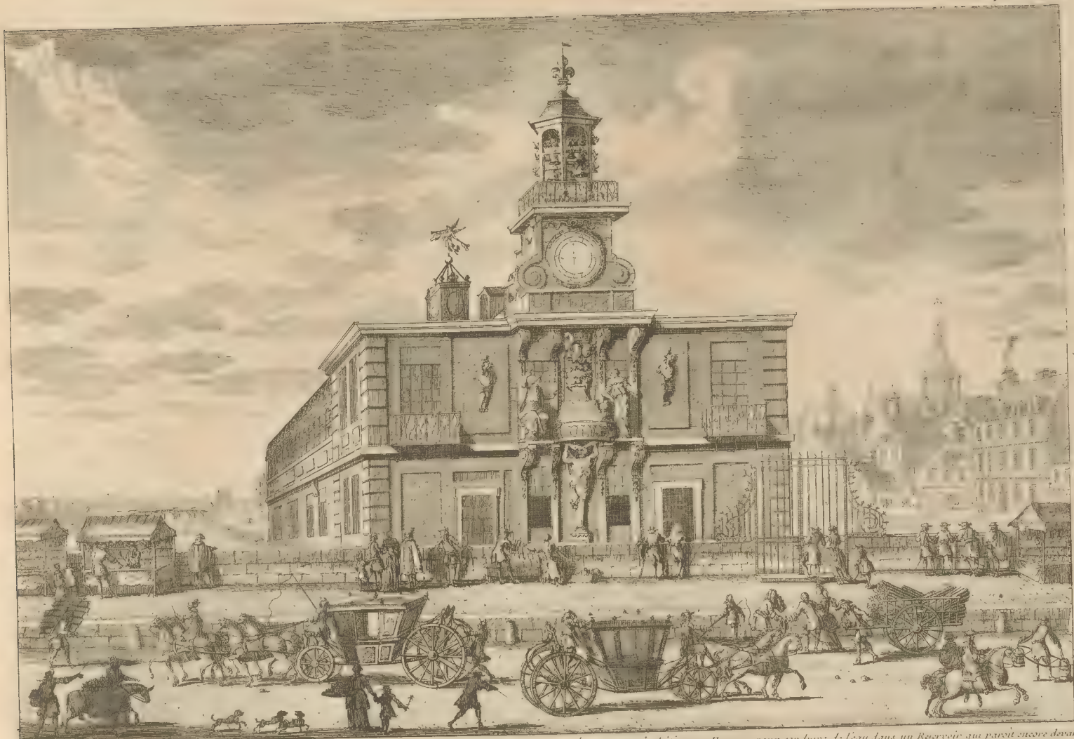
LA POMPE DE LA SAMARITAINE qui est derrière la seconde Arche du Pont-neuf du côté du Louvre, fut bâtie sous Henri 5. pour conduire de l'eau dans un Reservoir, qui paroit encore devant le Port de l'École mais ce Reservoir n'ayant point servi l'eau de cette Pompe qui est aspirante et de l'invention du S r Lohy, a été conduite par des tuyaux au Chateau et Lardin des Thuilleries dont elle fait jouer les jets du Parterre Les Escures de Notre Seigneur et de la Samaritaine, sont des copies de celle que fit aller Germain Pilon fameux Sculpteur. Le Timbre de l'Horloge est accompagné d'un Canillon qui sonne aux heures et qui a été jeté en 1684 que le Bâtimant a été aussi enrichi et augmenté de plusieurs ornemens, et d'un Cadran Anomique qui par le moyen d'une Renommée tournante au gré du vent, se hausse quand l'air est pesant et se baisse quand il est léger. A Paris chez M. Moitte, et chez l'Imprimeur à la Vierge, au N o 11, de la Rue
