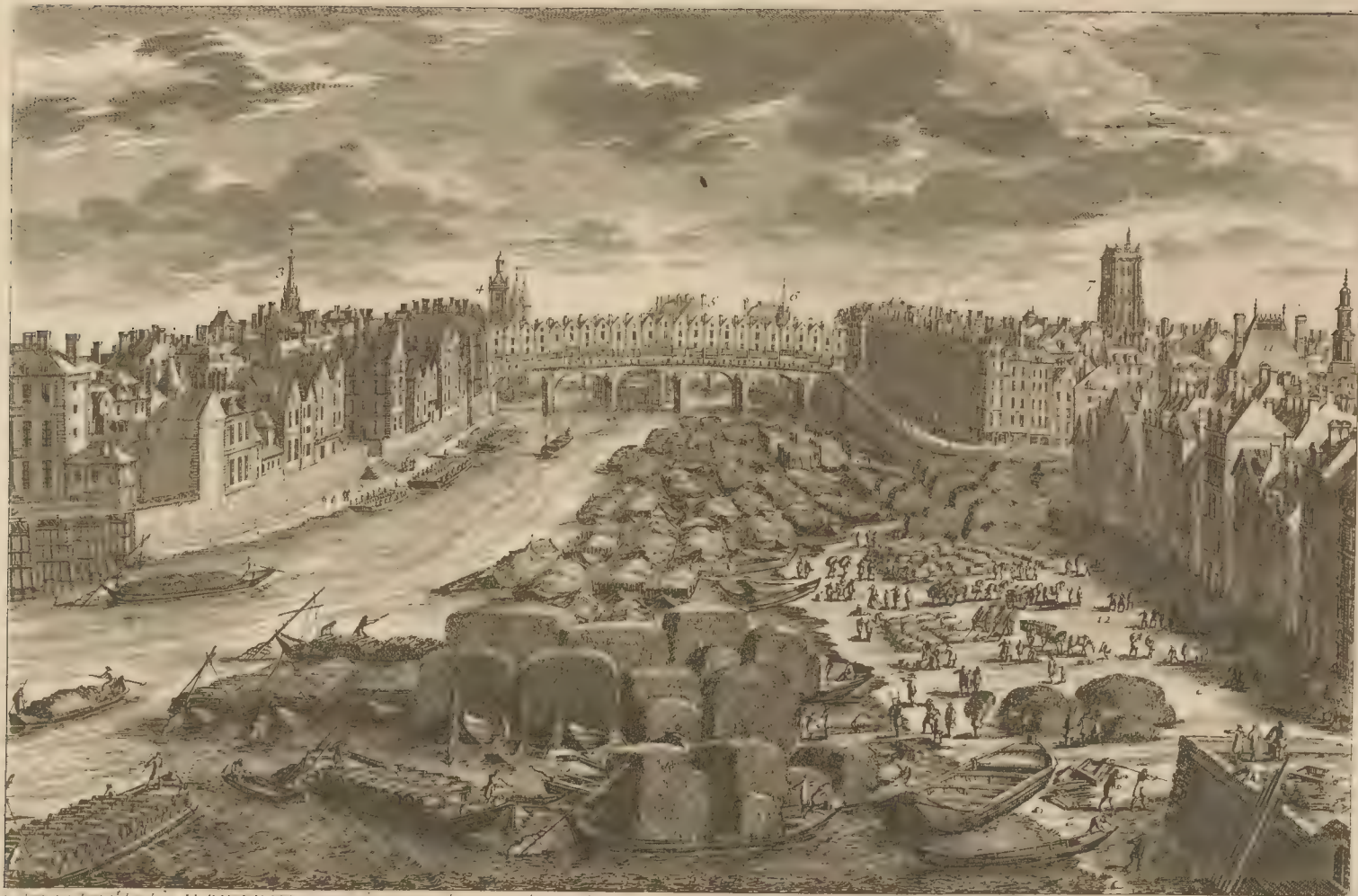
1. Tour St. Landei 2. Chapelle 3. Le Louvre 4. Le Mans 5. Le Mans 6. Le Mans 7. Le Mans 8. Le Mans 9. Le Mans 10. Le Mans 11. Le Mans 12. Le Mans LE PONT NOTRE DAME fut commencé l'An 1707 et achevé peu de tems après sur le dessin et par la conduite de Jean Le Blond, Cordelier Vermeuse celebre Architecte Il est bâti fort solidement d'une pierre tres dure, et chargé de 68. maisons qui furent embellies de quelques ornemens pour l'entrée de la Reine épouse de LOUIS LE GRAND LE QUAY PELLETIER , qui fut ouvert l'An 1675. à la place des maisons des Tanneurs et des Teinturiers, est un des plus utiles ouvrages de la Ville de Paris pour l'usage du Pont Notre Dame et de la Place de Greve. La Banquette pour les Gens de pied est suspendue sur une portion de Voûte qui va terminer dans la premiere Arche de ce Pont par une grande Trompe appareillée avec beaucoup d'artifice. A Paris Chez I. Mariette rue St. Jacques à la Vierge Avec Privilège du Roy... 8. La Pompe Notre Dame 9. Le Quay Pelletier 10. Le Port de la Greve 11. L'Hôtel de Ville 12. Le Quay de la...
