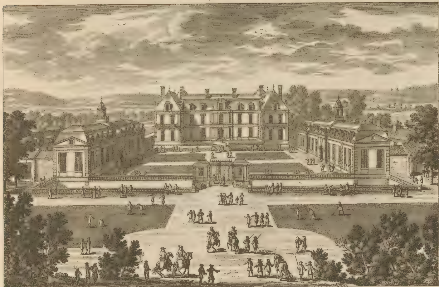
LA MAISON DE POMPONE
