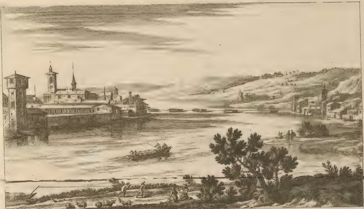
L'ARCNAL ET LE PONT DE CHAÎNE, qui ferme la Rivière de Saône à Lyon
