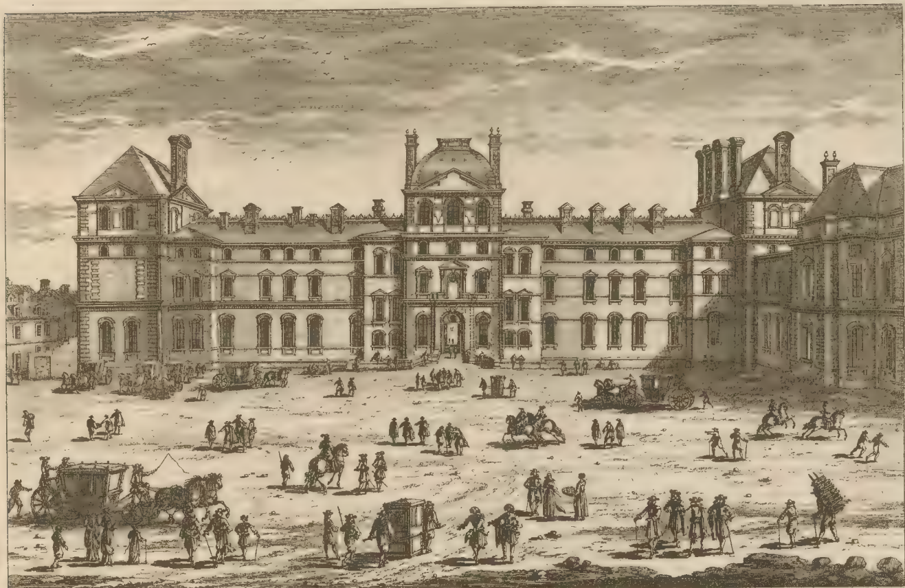
LE LOUVRE commença à recevoir une forme régulière l'année 1528. par les soins de François 1 er qui changea l'ordonnance gothique que ses prédécesseurs y avoient donnée Henri 2 e y ajouta de nouveaux ornemens d'Architecture. Henri 4. en fit faire la grande galerie, et Louis 14. la mis dans l'estat superbe où nous le voyons. Cette place regarde la rue Fremontau. Perelle Sculp.
