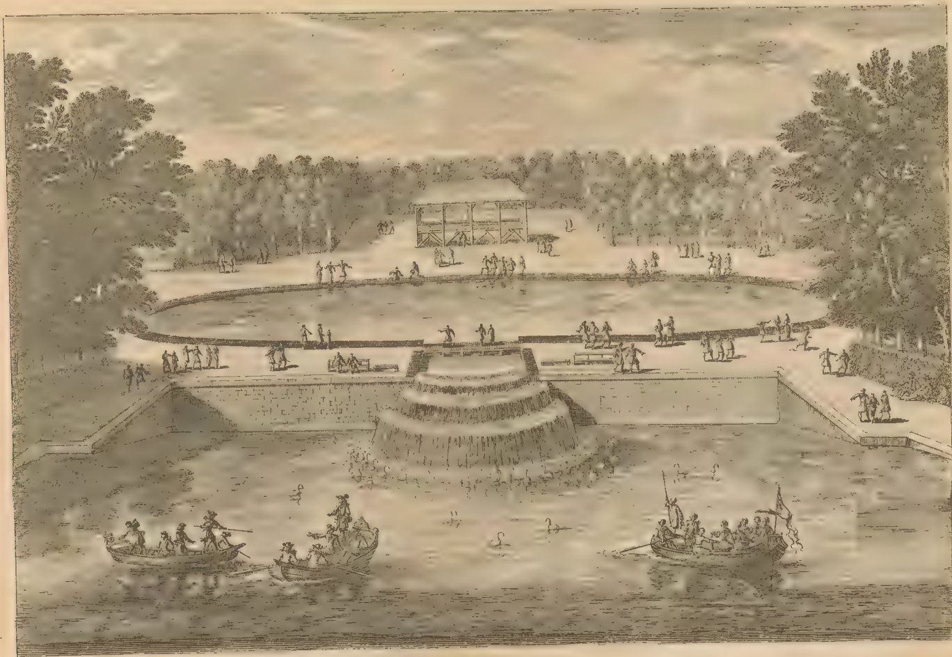
LA CASCADE A LA TÊTE DU CANAL DE CHANTILLY
